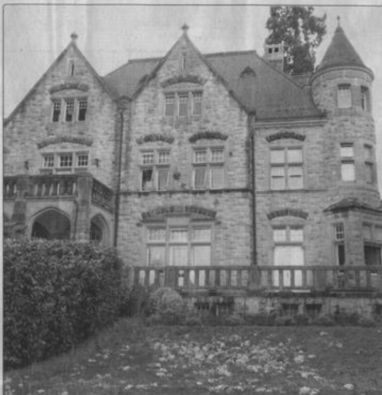
Mit der Gründung der Stiftung «Villa Alma» bekommt die Gemeinde «den Föifer und das Weggli»: Sie ist die Unterhaltskosten der Villa los, verliert das Gebäude nicht und bekommt noch zweieinhalb Millionen Franken dazu. Reto Schneider
